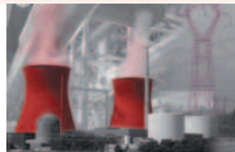
Geração de energia
