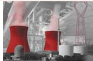
Geração de energia
